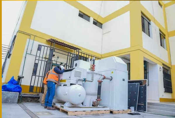
Instalación y puesta en marcha de Plantas VSA para Oxígeno en Hospital
