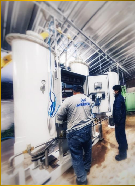
Izquierda.- Planta fija de oxígeno PSA
